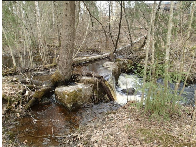
Patorakenne kuvattuna eri suunnista
