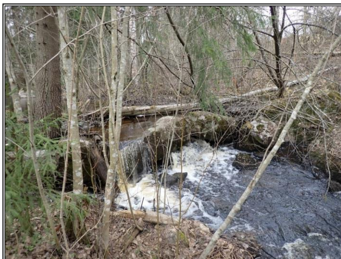
Patorakenne kuvattuna eri suunnista
